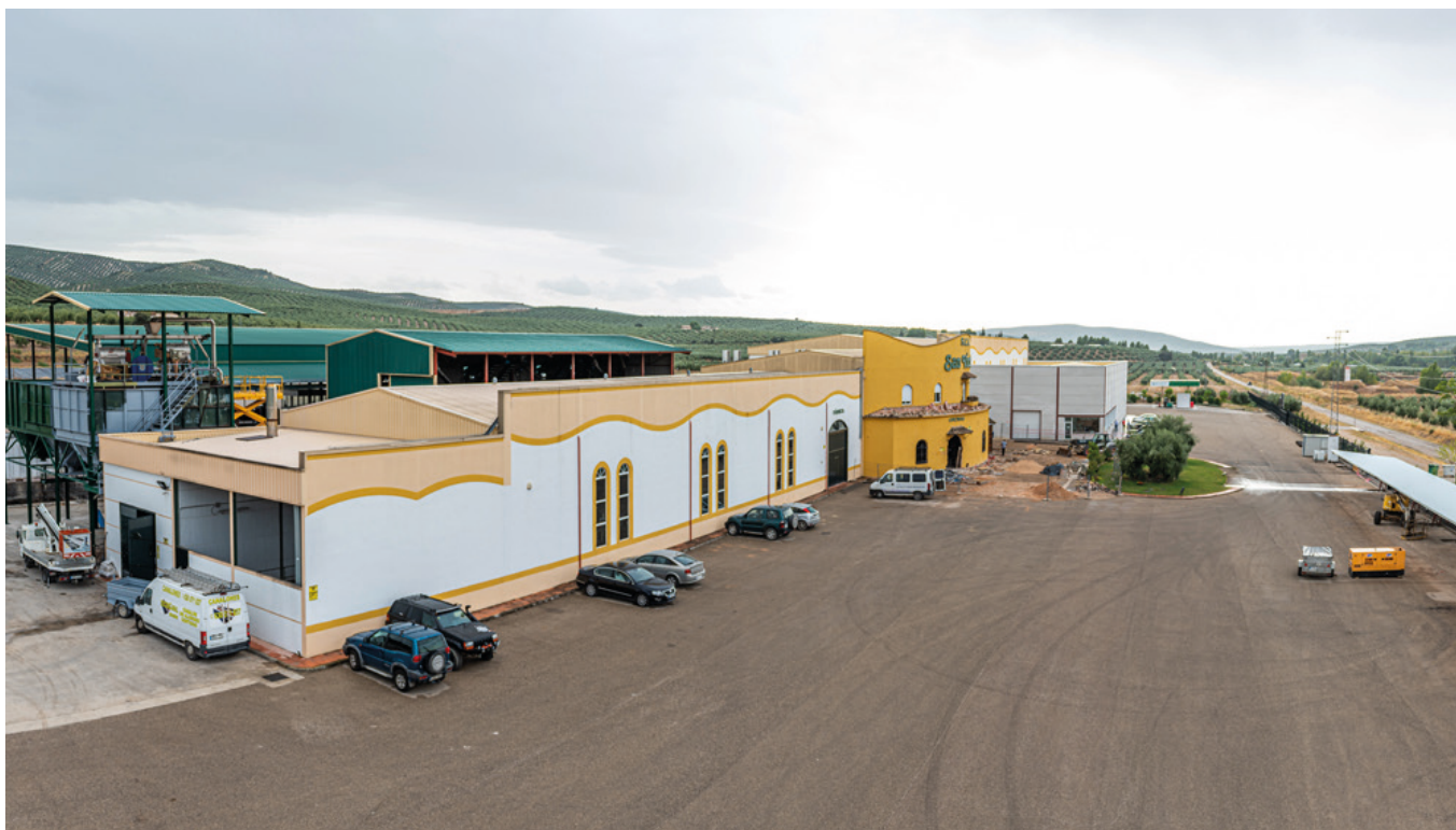
La cooperativa está a punto de terminar la ampliación y modernización de sus instalaciones.
